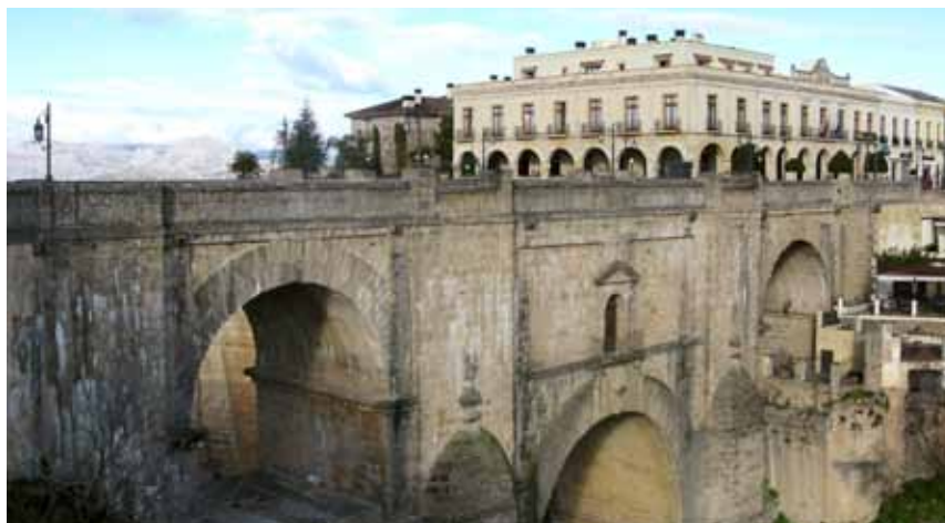
스페인 남부 론다의 상징인 높이 98m의 누에보 다리.
