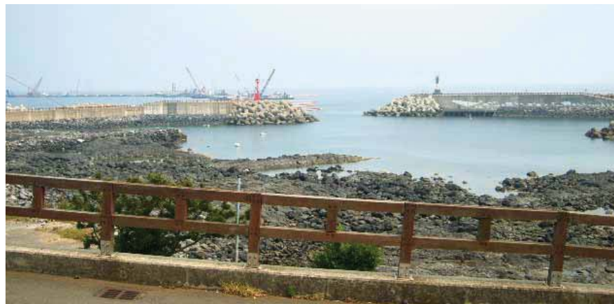
공사가 한창 진행중인 서귀포 항만.
